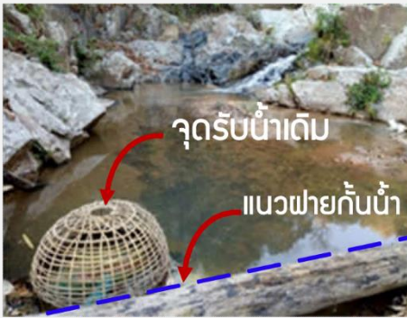
รูปที่ 1 จุดรับน้ำของระบบประปาของหมู่บ้านเดิมบริเวณด้านหน้าฝายเป็นที่สะสมตะกอน/ทราย ใบไม้ เศษวัชพืช ฯลฯ ที่ไหลมากับน้ำ
