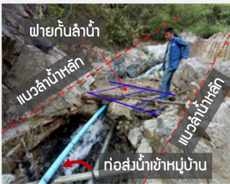
รูปที่ 2 จุดรับน้ำที่อยู่ในร่องน้ำหลัก จุดรับน้ำอยู่ใน ร่องน้ำหลัก ทำให้ตะกอน/ทราย ใบไม้ เศษวัชพืช ฯลฯ ที่ถูกพัดพามาตามลำธารไหลเข้าไปในท่อส่งน้ำ
