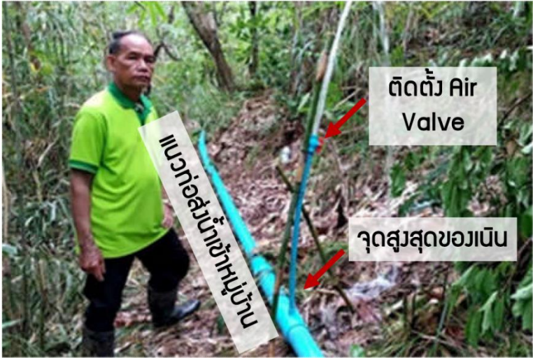
รูปที่ 13 แสดงจุดในการติดตั้ง valve ระบายอากาศ
