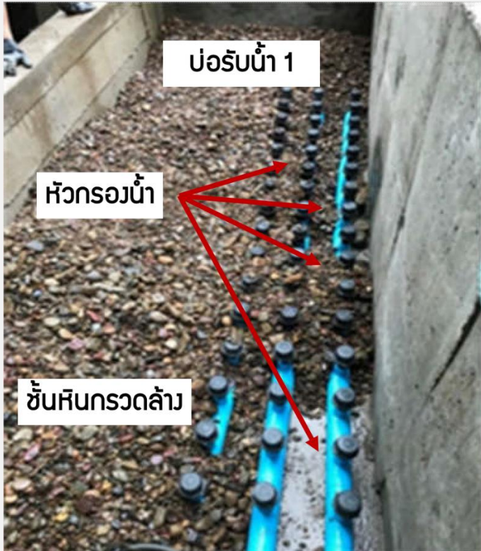
รูปที่ 9 ขั้นตอนการติดตั้งชั้นหินกรวดล้าง
