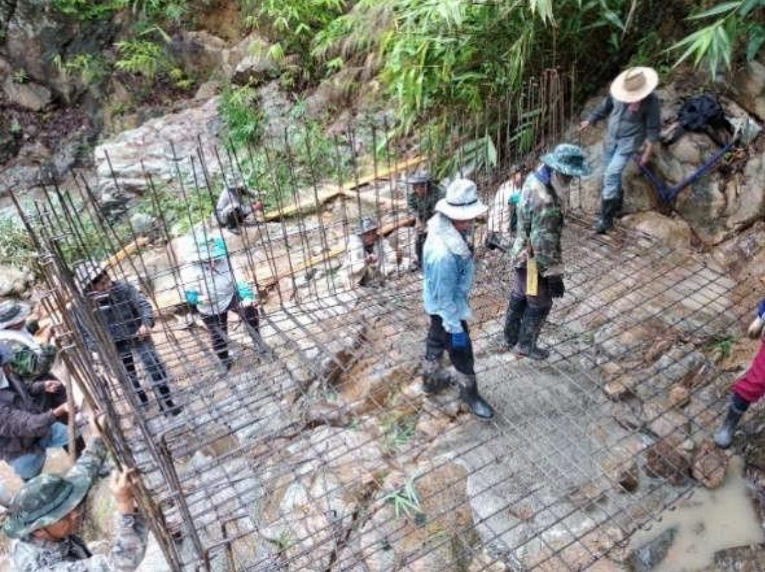
รูปที่ 6 การก่อสร้างจุดรับน้ำคอนกรีตเสริมเหล็กโดยได้รับความร่วมแรงร่วมใจ จากประชาชนในพื้นที่
