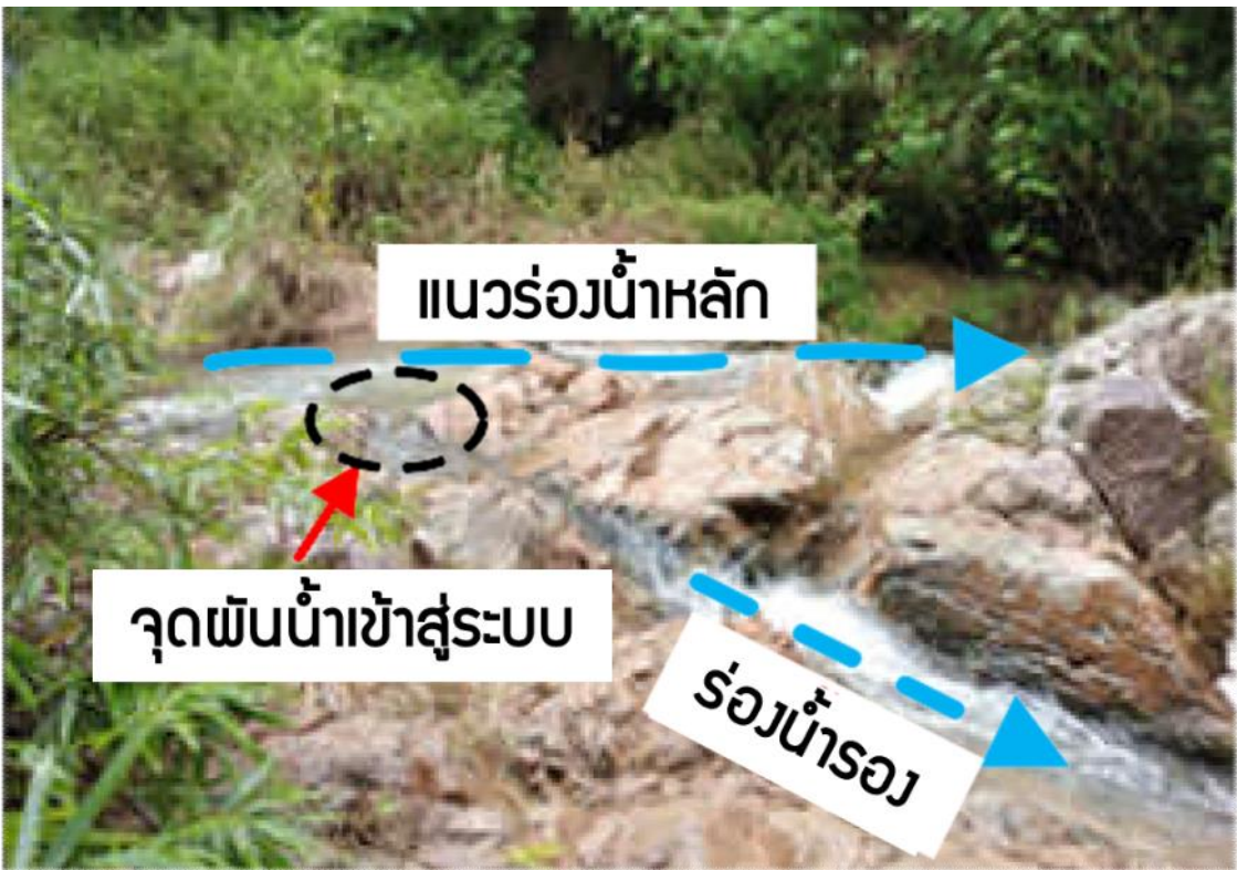
รูปที่ 5 (ก) แสดงจุดผันน้ำจากร่องน้ำหลัก
